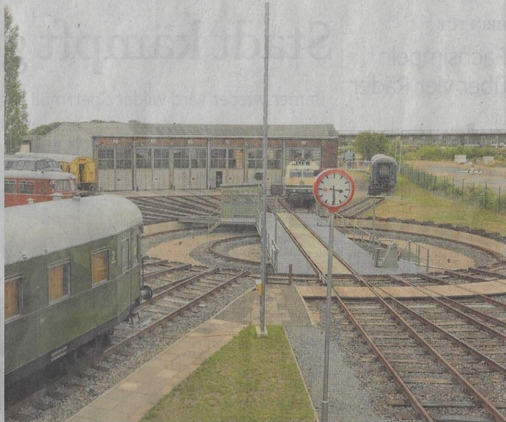
Links neben dem alten Lokschuppen soll der 2000 Quadratmeter große Anbau entstehen und zehn Gleise überspannen. Der Anbau wird nach hinten etwa vier Meter länger, damit auch die Reisezugwagen Platz haben.
