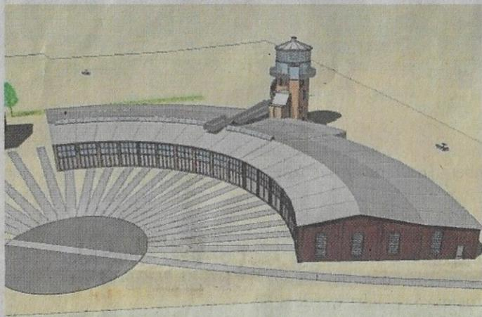
So soll der Lokschuppen mal aussehen: Rechts umspannt der alte Lokschuppen die ersten sechs Gleise. Dann kommt der geplante Anbau, der noch mal zehn Gleise umspannt. Die restlichen sechs der insgesamt 22 Gleise bleiben frei. In der Mitte des Ensembles steht der Turm, der dem früheren Wasserturm auf dem Gelände ähnelt. Seitlich des Turms ragt der Skywalk über das Dach des Lokschuppens. Von dort haben die Besucher bald freien Blick auf das Gelände.
