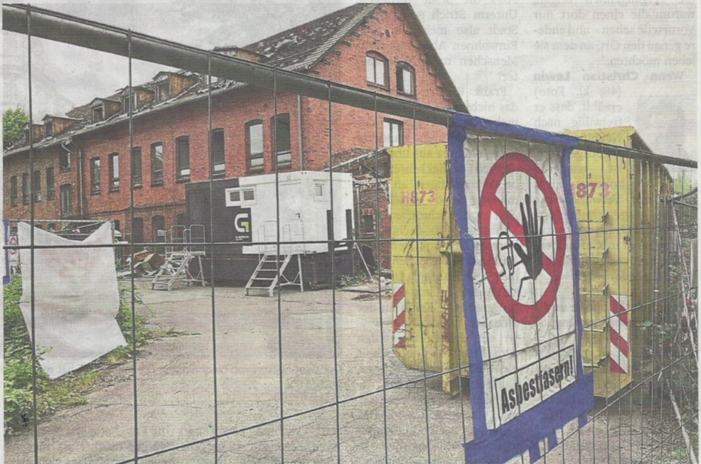
Zurzeit wird dieses Gebäude auf dem Gelände des künftigen Parks am ehemaligen Rangierbahnhof abgerissen.
